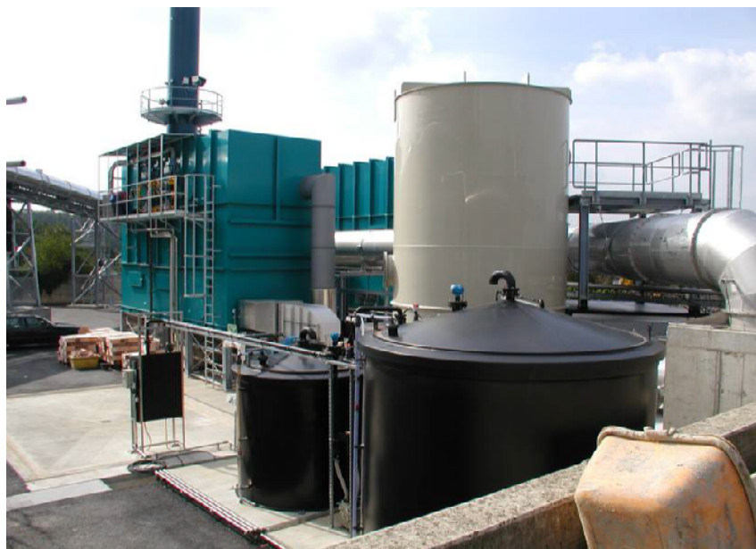
Abbildung 2 RTO-Anlage der MBA Singhofen, im Vordergrund der saure Wäscher
